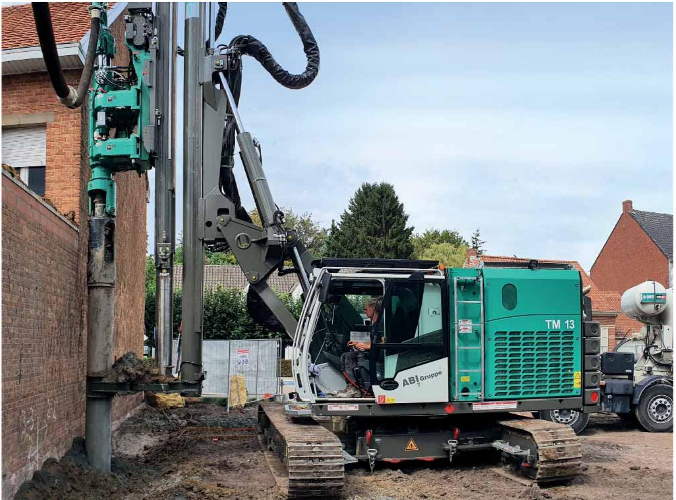
Herstellung einer überschnittenen Bohrspfahlwand mit einem VDW Bohrantrieb in einem minimalen Abstand zur bestehenden Bebauung. Der Bohr- und Betoniervorgang erfolgt in einem Zug, nach dem Abteufen wird während des Ziehens betoniert.
