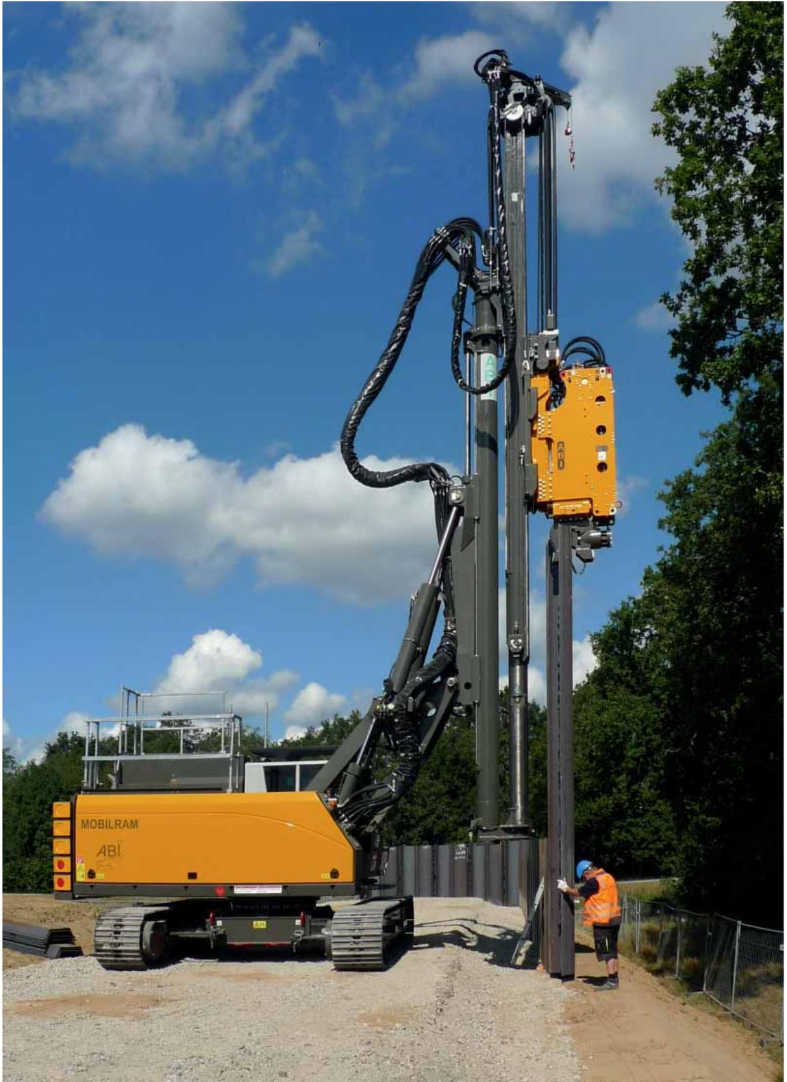
Ein klassischer Einsatz für das ABI MOBILRAM-System mit Vibrator: Die Installation einer Spundwand.
