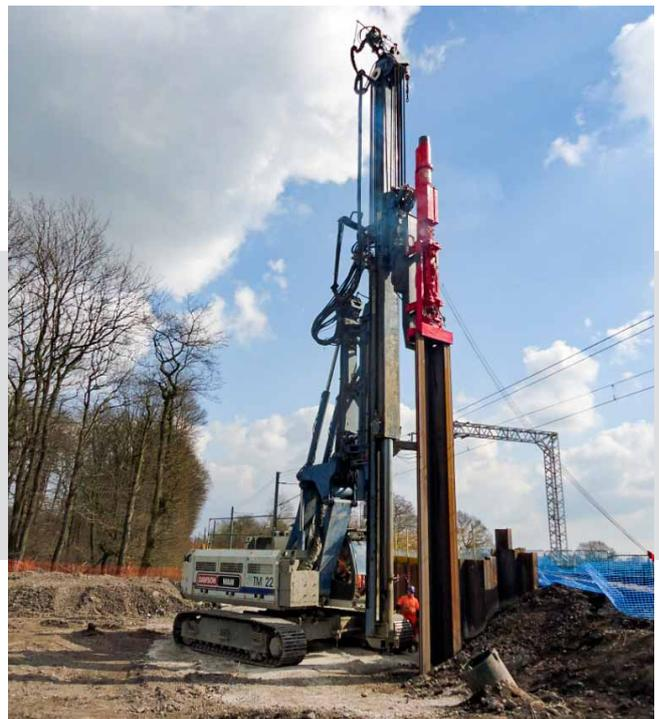
Schlagen von Spundwandprofilen. Der DELMAG Dieselbär wird oft zum Nachschlagen oder zum Einbinden von Rammgut in tragfähige Schichten eingesetzt.
