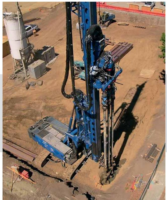
Bodenmischen mit einem Triplemix Bohrantrieb. In einem Arbeitsgang werden drei überschneitene Mischpfähle installiert.
