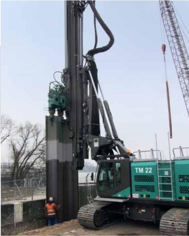
Mit dem Hydro-Press-System HPZ werden vier Spundwandprofile in einer Schrittfolge statisch in den Boden gepresst.
