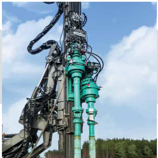
Beim Bodenmischen kann die Produktivität mit dem Einsatz von Mehrfachbohrantrieben gesteigert werden.
