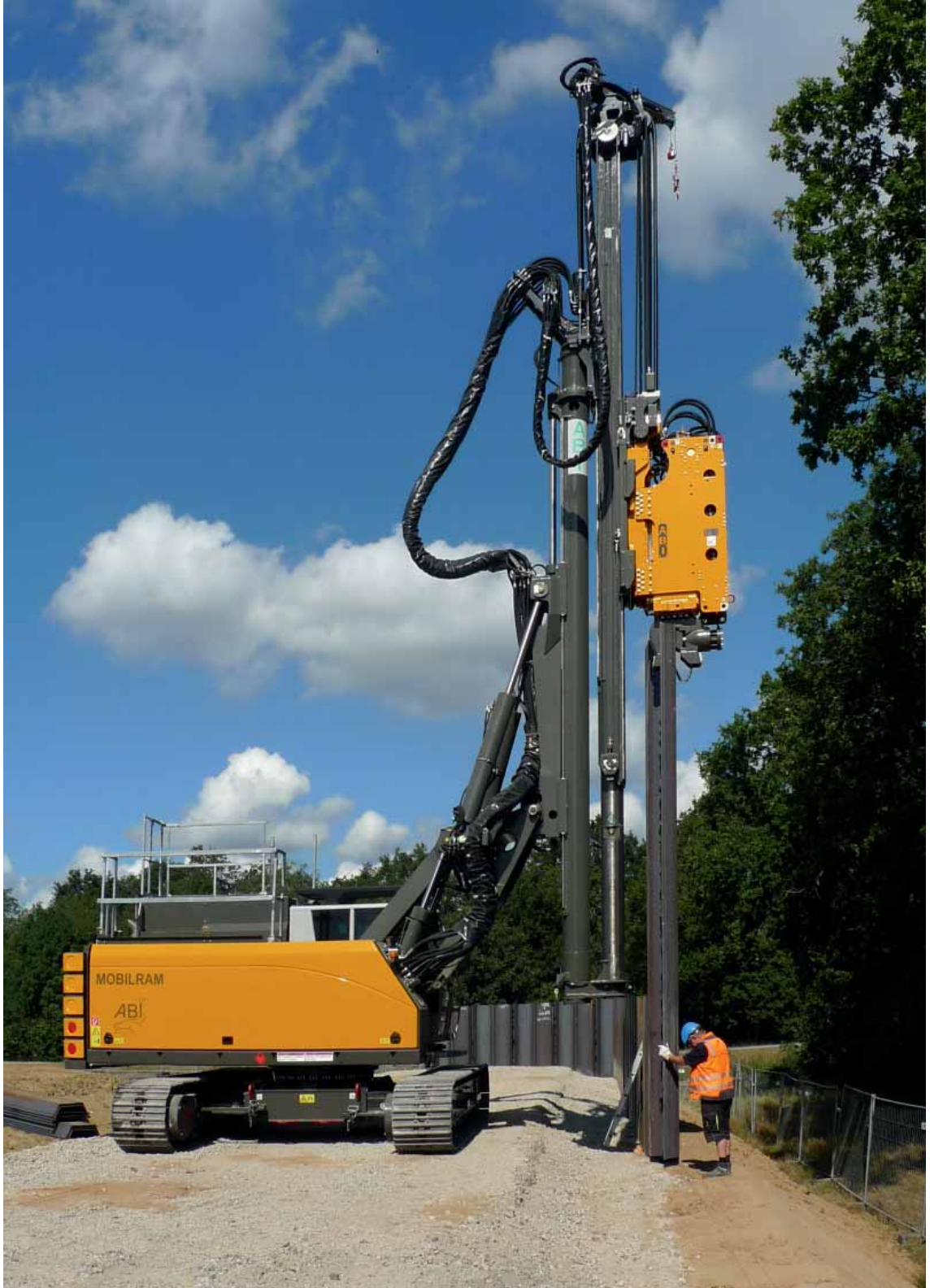
Ein klassischer Einsatz für das ABI MOBILRAM-System mit Vibrator: Die Installation einer Spundwand.
