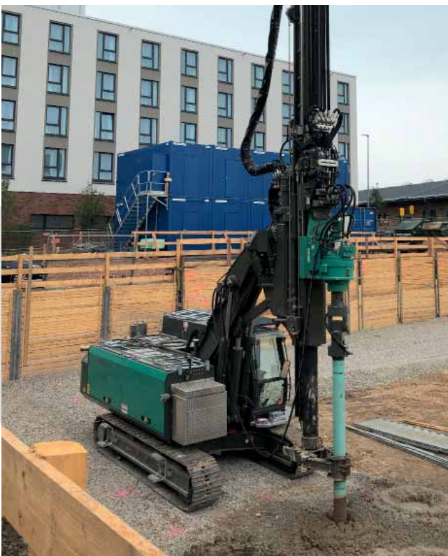
Erhöhung der Tragfähigkeit des Bodens durch Mischpfähle. Der vorhandene Boden wird mit einer Suspension durchmischt.
