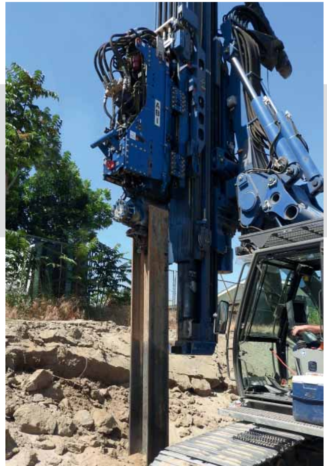
Doppel-T-Träger werden oft zur Verbesserung der Tragfähigkeit des Bodens eingesetzt.
