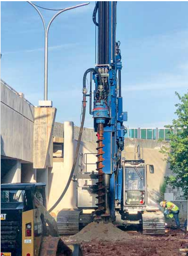
Herstellung von Schneckenortbetonpfählen: Nach dem Erreichen der Solltiefe wird während des Ziehvorgangs durch die Hohlwelle der Schnecke Beton gepumpt.
