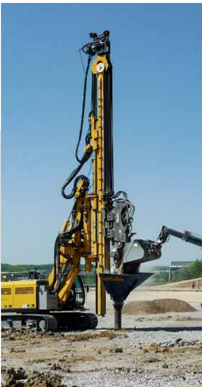
Erhöhung der Tragfähigkeit des Bodens durch das Einbringen von Schotterssäulen.
