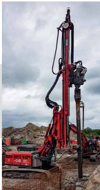
In verdrängbaren Böden können Betonpfähle mit dem Vollverdränger-Verfahren hergestellt werden.
