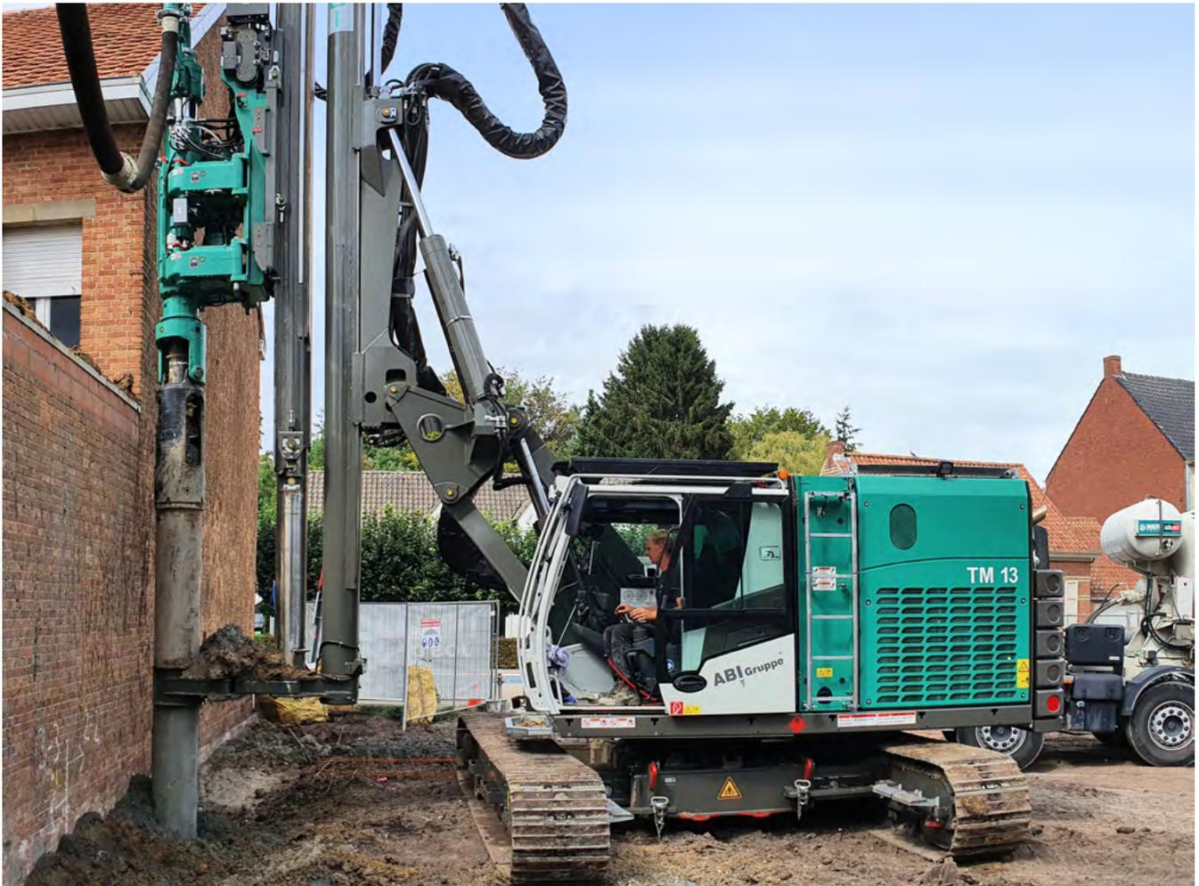
Herstellung einer überschnittenen Bohrpfahlwand mit einem VDW Bohrantrieb in einem minimalen Abstand zur bestehenden Bebauung. Der Bohr- und Betoniervorgang erfolgt in einem Zug, nach dem Abteufen wird während des Ziehens betoniert.
