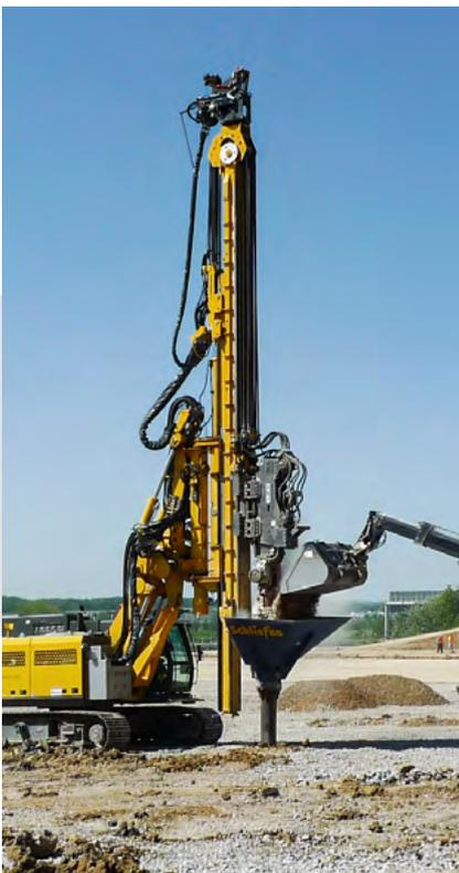
Erhöhung der Tragfähigkeit des Bodens durch das Einbringen von Schottersäulen.
