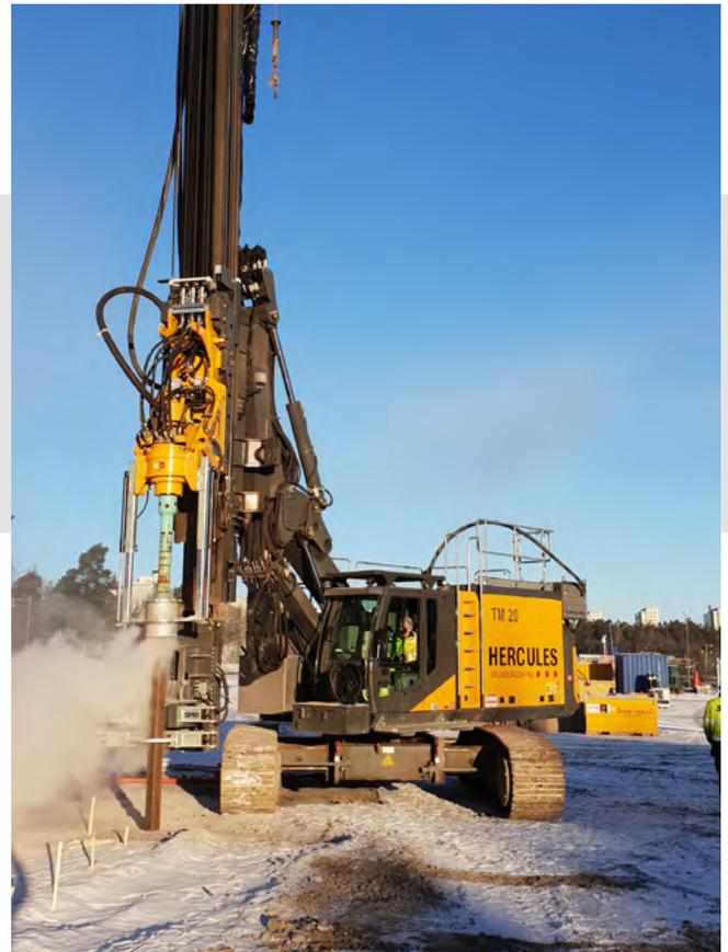
In harten, felsigen Böden werden Bohrungen mit einem Imlochhammer hergestellt.
