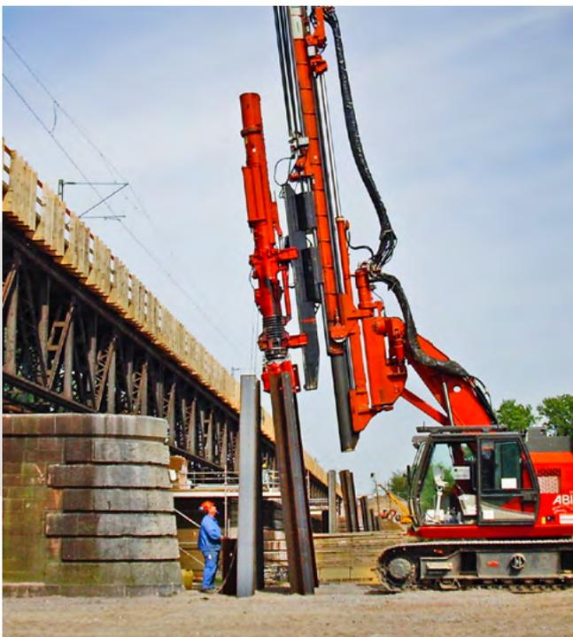
Schlagen von Doppel-T-Trägern mit einem DELMAG Dieselbär. Durch die DELMAG Rammformel kann ein Tragfähigkeitsnachweis erbracht werden.
