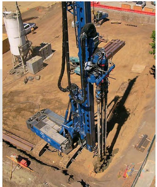
Bodenmischen mit einem Triplemix Bohrantrieb. In einem Arbeitsgang werden drei überschichtete Mischpfähle installiert.
