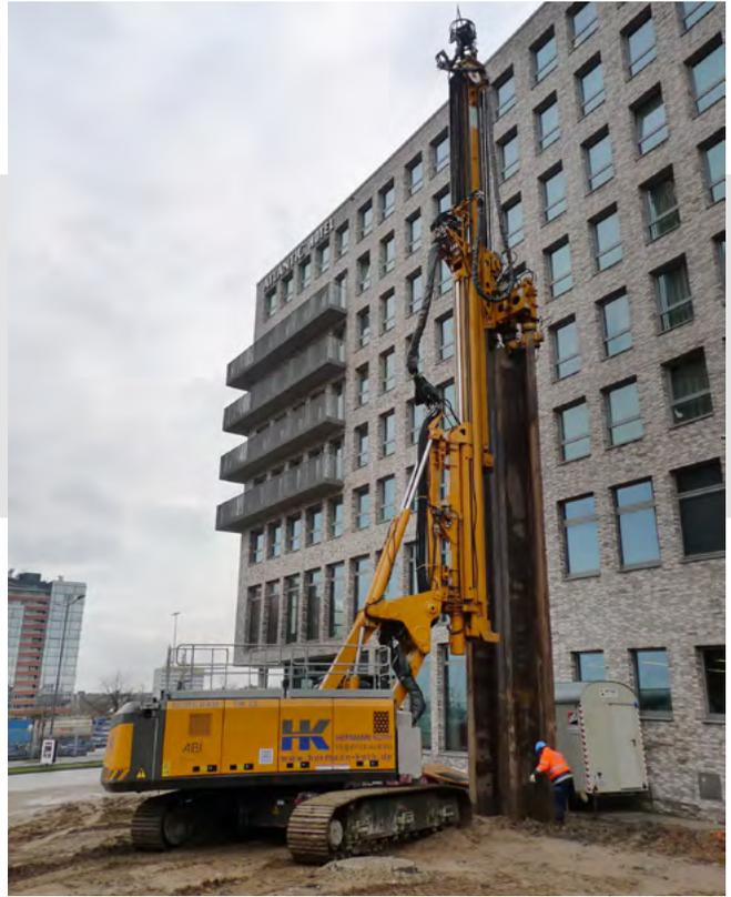
Statisches Pressen direkt vor bestehenden Gebäuden. In manchen Fällen muss der Boden durch Vorbohren gelockert werden.
