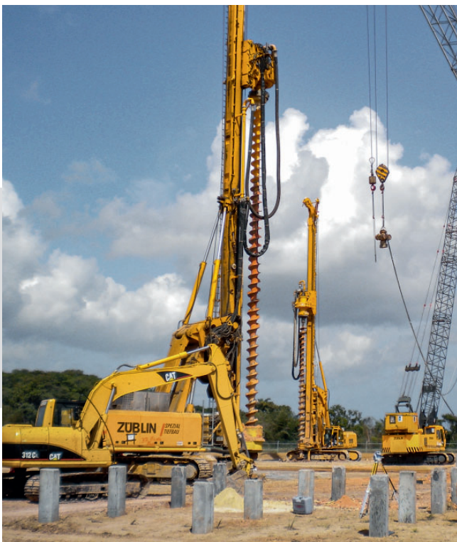
Herstellung von Schnecken-Ortbeton-Pfählen. Die erreichbare Tiefe kann mit einer Betonierkellystange verlängert werden.
