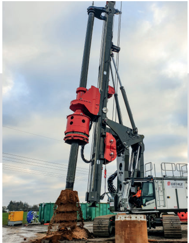
Drehbohranlage mit Kellystangenführung: Bei geneigten Bohrungen wird die Kellystange am oberen Ende zusätzlich geführt um ein Kippen der Kellystange zu verhindern.
