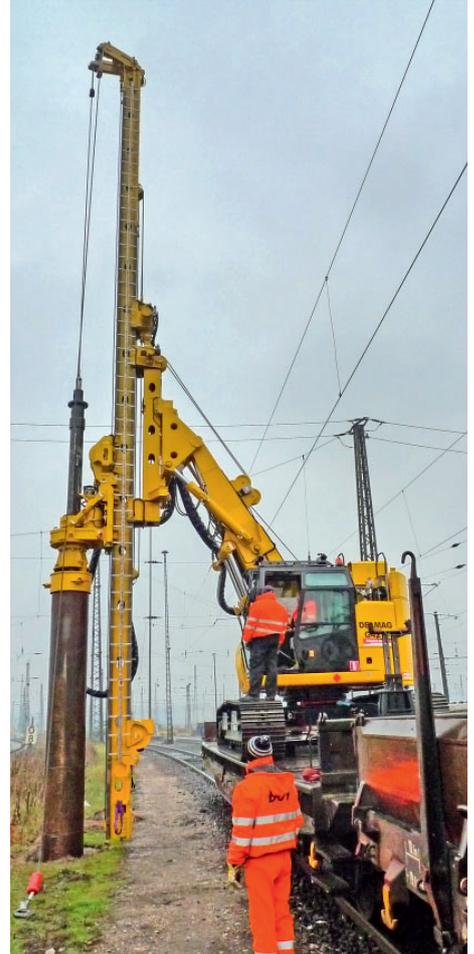
Zum Einbringen von Masten entlang der Bahngleise wurde z. B. der Starrmäkler G 42 entwickelt. Die G 42 ist für den Betrieb mit einem DELMAG Dieselmotor ausgelegt und kann direkt von einem Waggon aus arbeiten. Je nach Transportmittel, Waggon oder Tieflader, kann der Mäkler entweder nach vorne oder nach hinten abgelegt werden. Zusätzlich wurde der Einsatzbereich des Rammmäklers um das Bohren erweitert. Die G 42 B verfügt über ein Vorschubsystem und kann z. B. für das Kellybohren eingesetzt werden.
