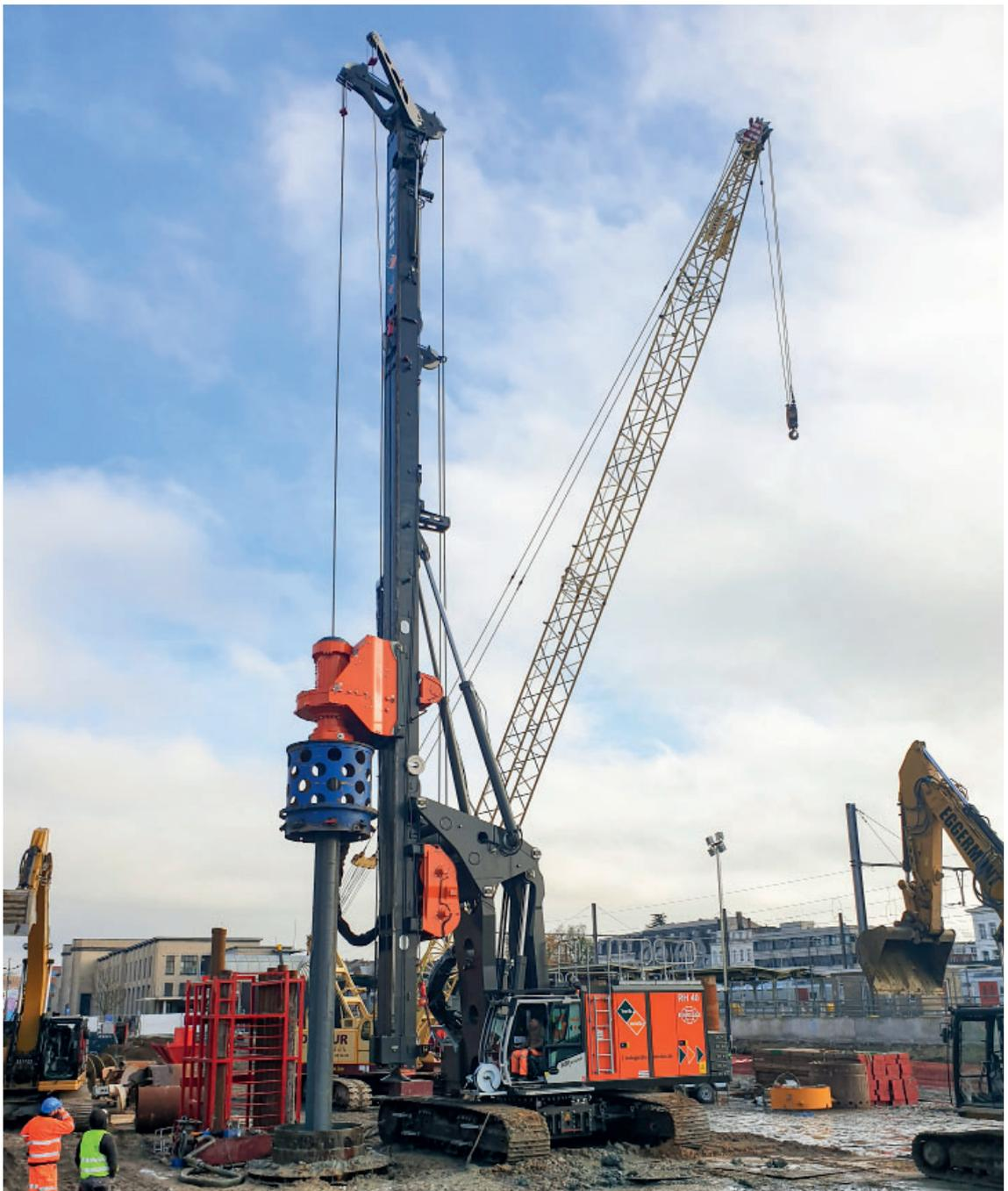
Das größte Modell der DELMAG Drehbohranlagen aufgebaut auf ABI Trägergerät T110D bei der Herstellung von Pfählen mit einem Durchmesser von 1800 mm und einer Tiefe von 40 m im Kellybohrverfahren.
