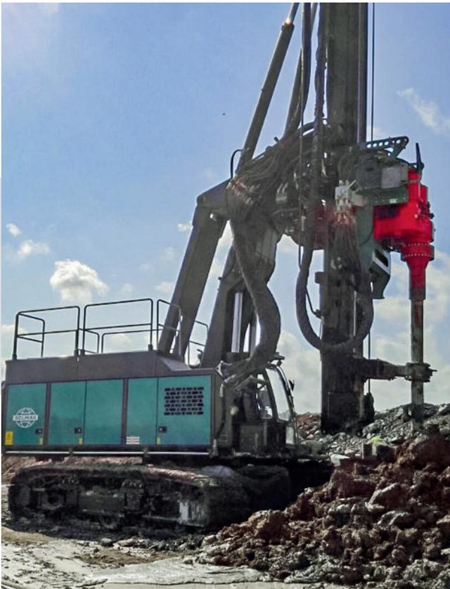
Bodenmischen WSM mit einem Bohrantrieb RHP 150 zur Erhöhung der Tragfähigkeit des Bodens. Das vorhandene Bodenmaterial wird mit einer Suspension durchmisch.
