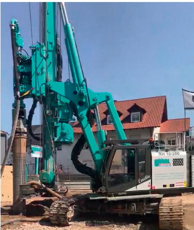
DELMAG Drehbohranlage beim VDW-Bohren: Der Pfahl wird in einem Zug erstellt. Direkt nach dem Abteufen erfolgt das Betonieren während des Ziehvorgangs.
