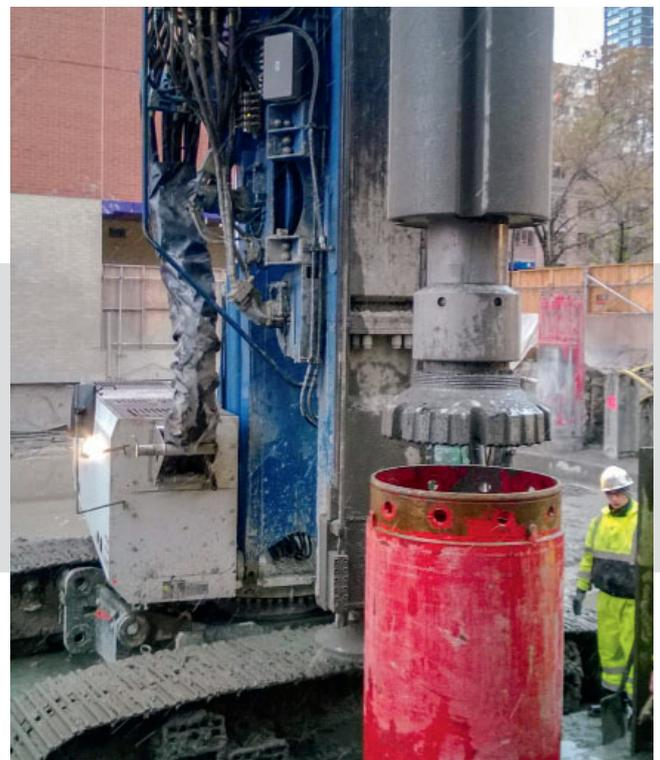
DELMAG Drehbohranlage beim Bohren mit einem Imlochhammer in harten, felsigen Böden.
