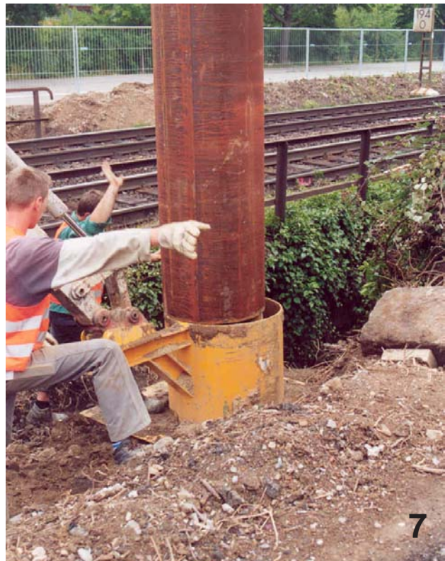
Bild 7: Positionieren der Bohreinrichtung (z. B. mittels Schablone)
