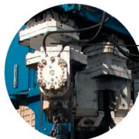
Die Hydropresse wird nach unten gefahren, bis die Presseinheiten komplett eingefahren sind. Dieser Vorgang wird wiederholt bis die Profile die gewünschte Verbautiefe erreicht haben.
