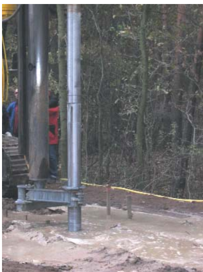
Das bereits entstandene Gemisch aus Zementsuspension und Bodenmaterial wird beim Hochziehen des Mischkopfes nochmals gemischt und weiter mit Suspension angereichert.
